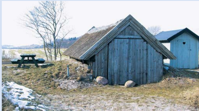
Die Bootsschuppen südlich von Stengade Strand
